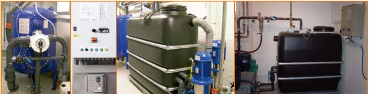
Spülbarer Kiesfilter (Tiefenfilter)
